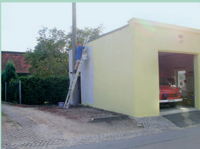
Neuer Außenanstrich für das Feuerwehrdepot Zadel durch den Kameraden Armin Klunker
