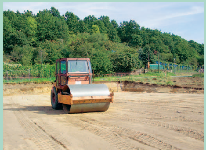
Bolzplatzausbau mit Erweiterung des Parkplatzes im ehemaligen Gärtnergelände in Nieschütz
