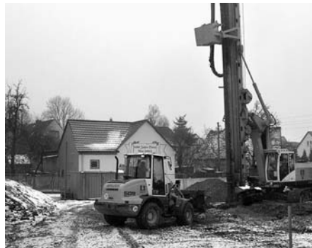
Baugrundverbesserung für das neue Feuerwehrgerätehaus in Diera
