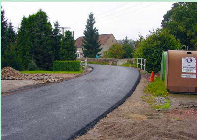
Straßenwiederherstellung nach Abwasserkanalverlegung in Wölkisch, Naundorfer Weg
