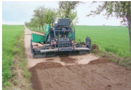
Landwirtschaftlicher Wegebau – hier: Alter Kirchweg Nieschütz-Zadel (2. Bauabschnitt)
