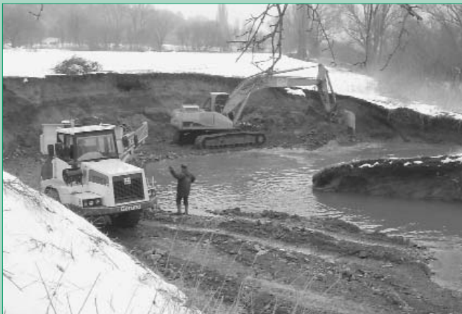
Bauarbeiten zur Sicherung des Trinkwasserdükers an der Mündung des Ketzerbaches
