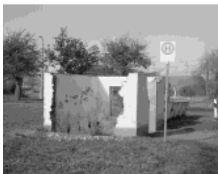
Abriss Buswartehaus Naundorf-Hebelei
