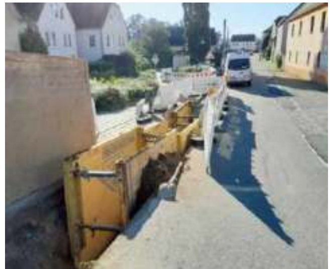
Die Baumaßnahme führte auch über die Feldstraße.
