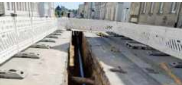
Neuverlegung der Rohrleitungen auf der Lange Straße.
