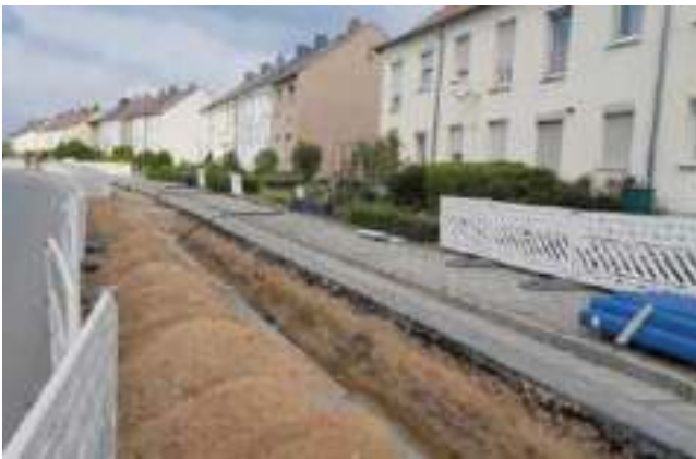
In der Alleestraße wurden alte Grauguss-Trinkwasserleitungen durch PE-Leitungen ersetzt.
