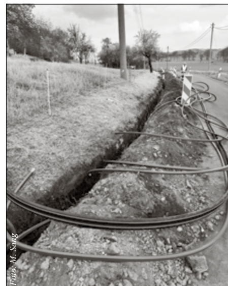
Breitbandausbau im OT Golk
