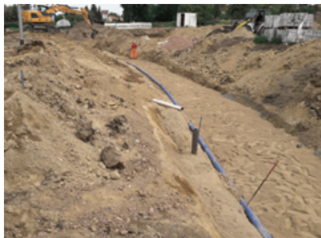
Die Baustelle im Bereich der Mertitzer Straße beim Neubau des Kreisverkehrs.
