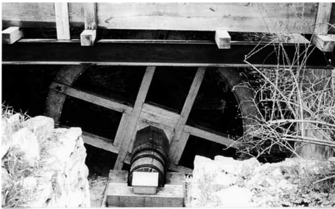
Abb. 16 Das Wasserrad / Mühlrad Ansicht von außen – oben der Kasten mit dem Wasserzulauf
