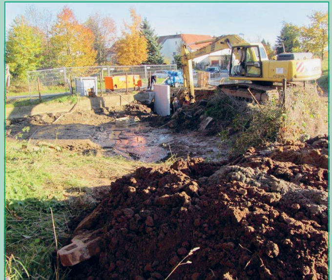
Instandsetzung Rückhaltebecken mit Feuerlöschfunktion in Niedermuschütz
