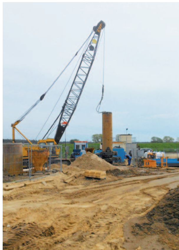
Ein Seilbagger im Einsatz bei den Kies austauschbohrungen. Foto: WRG
