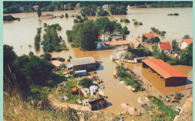
Gelände des Bauhofes in Kleinzadel
