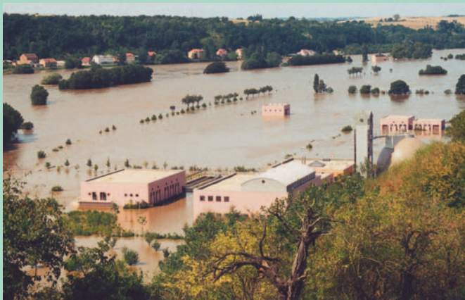
Kläranlage zwischen Karpfenschänke und Kleinzadel
