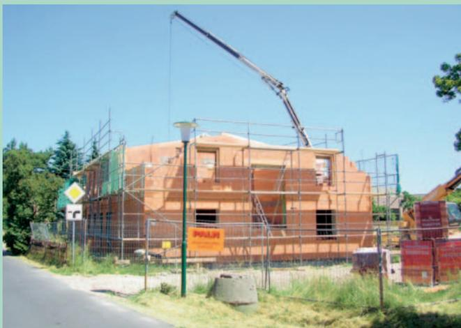
**Baufortschritt im Juni 2010 – der Rohbau steht, die Dachbinder werden errichtet**
