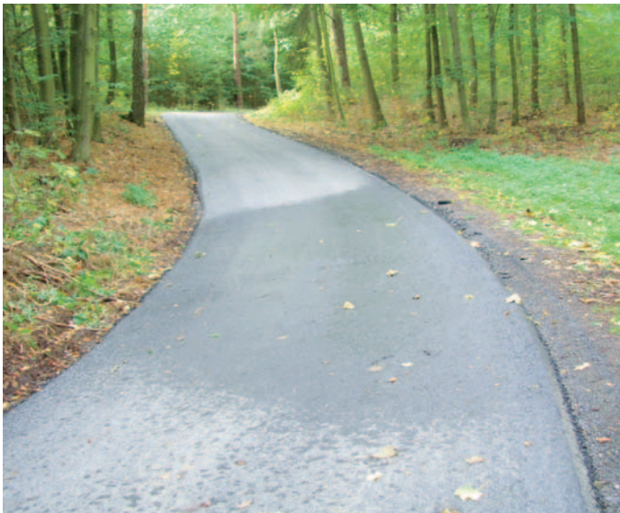
Straße Golk-Löbsal kurz vor Beendigung der Baumaßnahme
