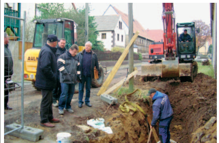
Beginn der Baumaßnahme, Verlegung Regenwasserkanal 2. v.l. Bürgermeister Friedmar Haufe, 5. v.l. Herr Weinke, Ing.-Büro
