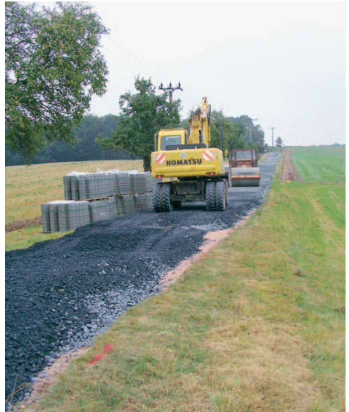
Beim Ausbau der Verbindungsstraße Löbsal – Radewitz
