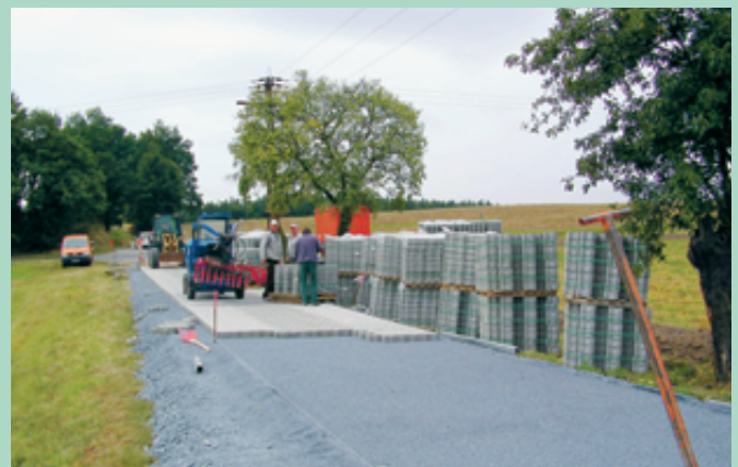
Ausbau der Verbindungsstraße Löbsal – Radewitz
