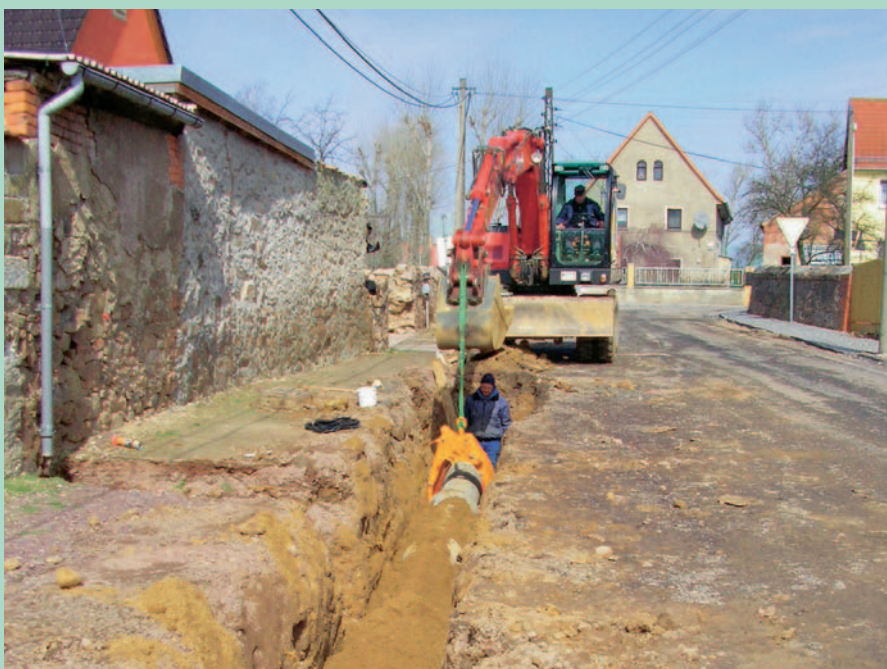
Beginn der Bauarbeiten am Dorfanger Zadel
