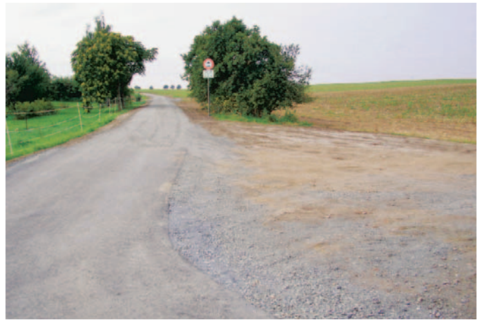
Ausbau der Panzerstraße in Naundörfel (Blick zur Kreisstraße Diera – Ockrilla)
