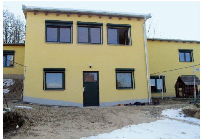
Kindertagesstätte Nieschütz nach Abschluss des 2. Bauabschnittes
