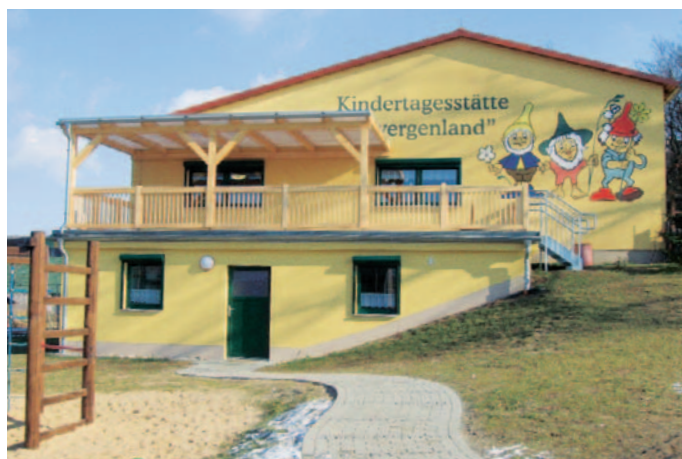
Abschluss des 1. Bauabschnittes in der Kindertagesstätte Nieschütz
