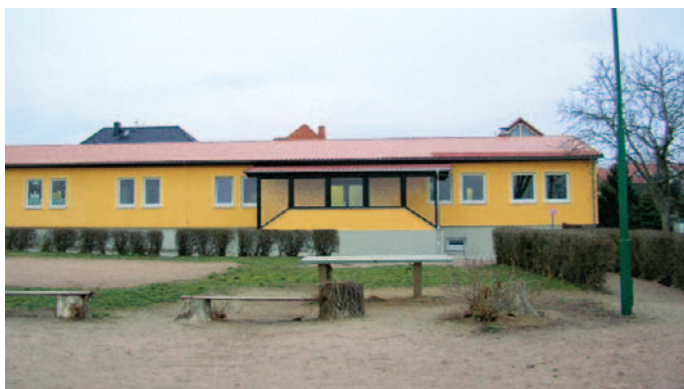
Hort Zadel nach Fertigstellung der Umbaumaßnahmen
