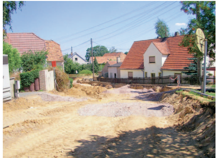
Baufortschritt beim Kanal- und Straßenbau in Wölkisch im Bereich Anbindung an die B 6/„Zur alten Schmiede“
