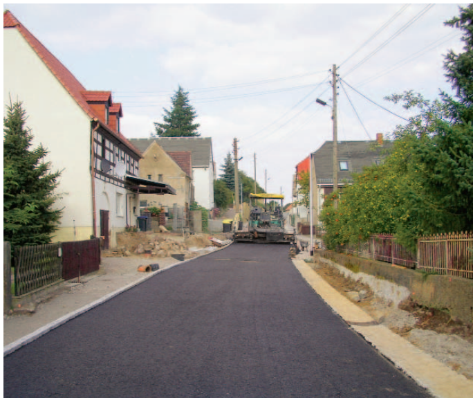
Straßenwiederherstellung nach Abwasserkanalverlegung in Wölkisch „Zur alten Schmiede“
