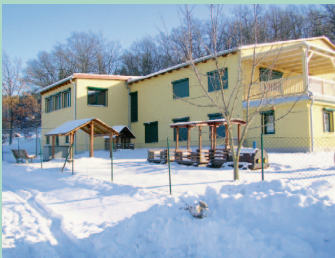
Kindertageseinrichtung „Zwergenland“ Nieschütz – neue Ansicht nach Gesamtfertigstellung
