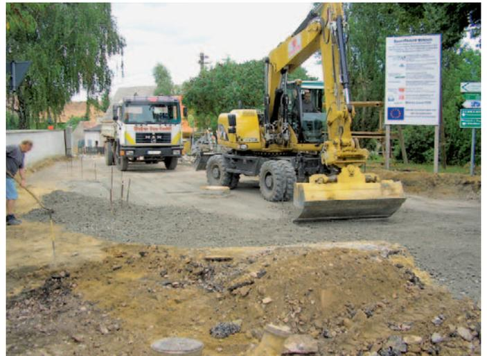
Baufortschritt Wölkisch – Arbeitsstand kurz vor Einbringung der Schwarzdeckentragschicht
