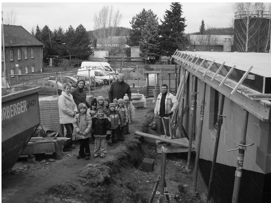
„Baubehegung“ im Kindergarten Nieschütz
