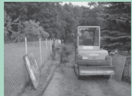
Trink- und Schmutzwasserleitungsverlegung in Nieschütz, Ringstraße
