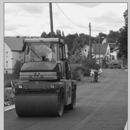
Baufortschritt Niedermuschütz Straße
