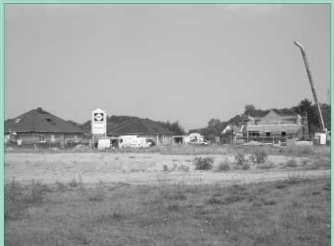
Baugeschehen im Bebauungsgebiet „Nieschütz I“. In diesem Jahr entstanden bisher zwei neue Häuser, ein drittes ist in Vorbereitung.
