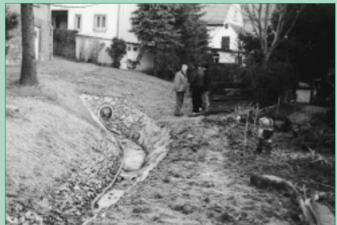
Instandsetzung und Neugestaltung Rietzschgenbach in Zehren
