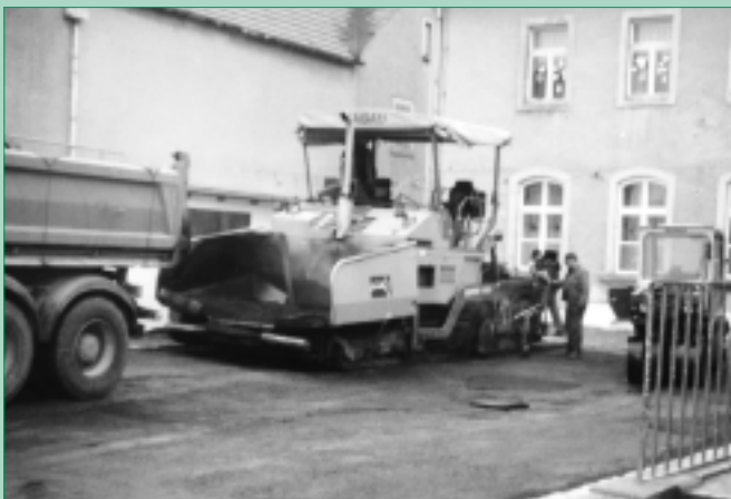
Bauarbeiten im Schulhof Zadel
