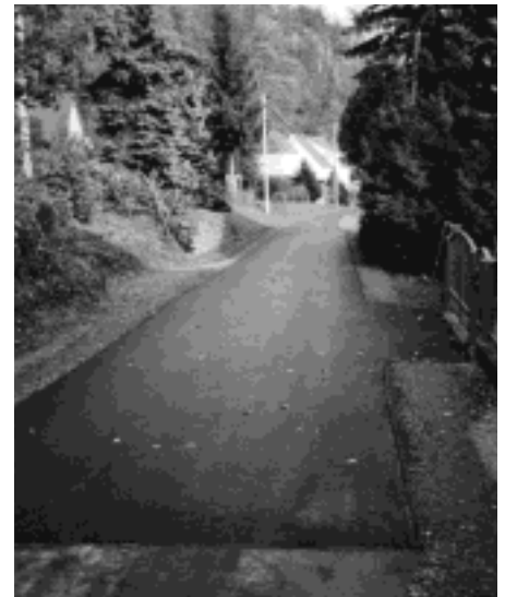
Erneuerung des Fahrbahnbelages der Jahnatalstraße im OT Keilbusch
