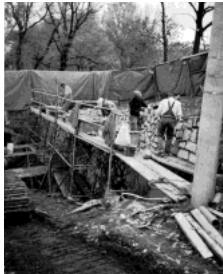
Instandsetzung der Stützwand am Elberadweg im OT Nieschütz
