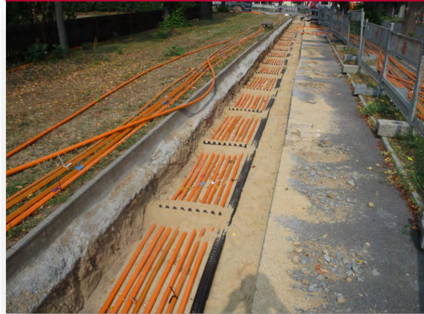
Trasse Rohrverband im Gehweg
