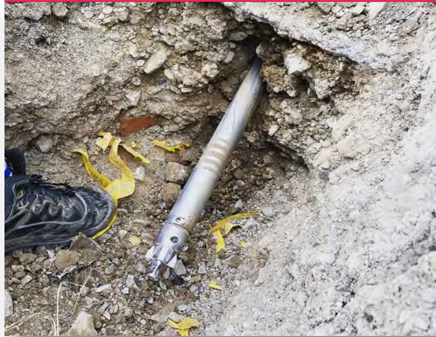
geschlossener Tiefbau (z.B. Erdrakete)
